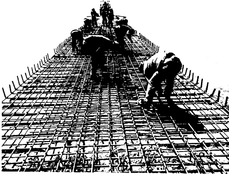
FOTO 01: Armado de acero en losa del día 01/07/19
